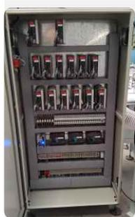
El tablero eléctrico está compuesto por 3 PLC en red, 14 Drivers de servomotor, una fuente de 24vcc, termomagnéticas y borneras. Estos elementos permiten comandar velocidades con gran confiabilidad y precisión; También reducen el mantenimiento al mínimo.
