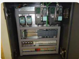
Tablero con PLC, Drivers de servomotor, Inverters, Relays de Estado Sólido y termomagnéticas. Estos elementos permiten comandar velocidades y temperaturas con gran confiabilidad y precisión; También reducen el mantenimiento
