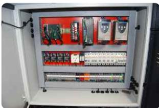
Tablero con PLC, Inverters, Relays de Estado Sólido y termomagneticas. Estos elementos permiten comandar velocidades y temperaturas con gran confiabilidad y precisión; También reducen el mantenimiento
